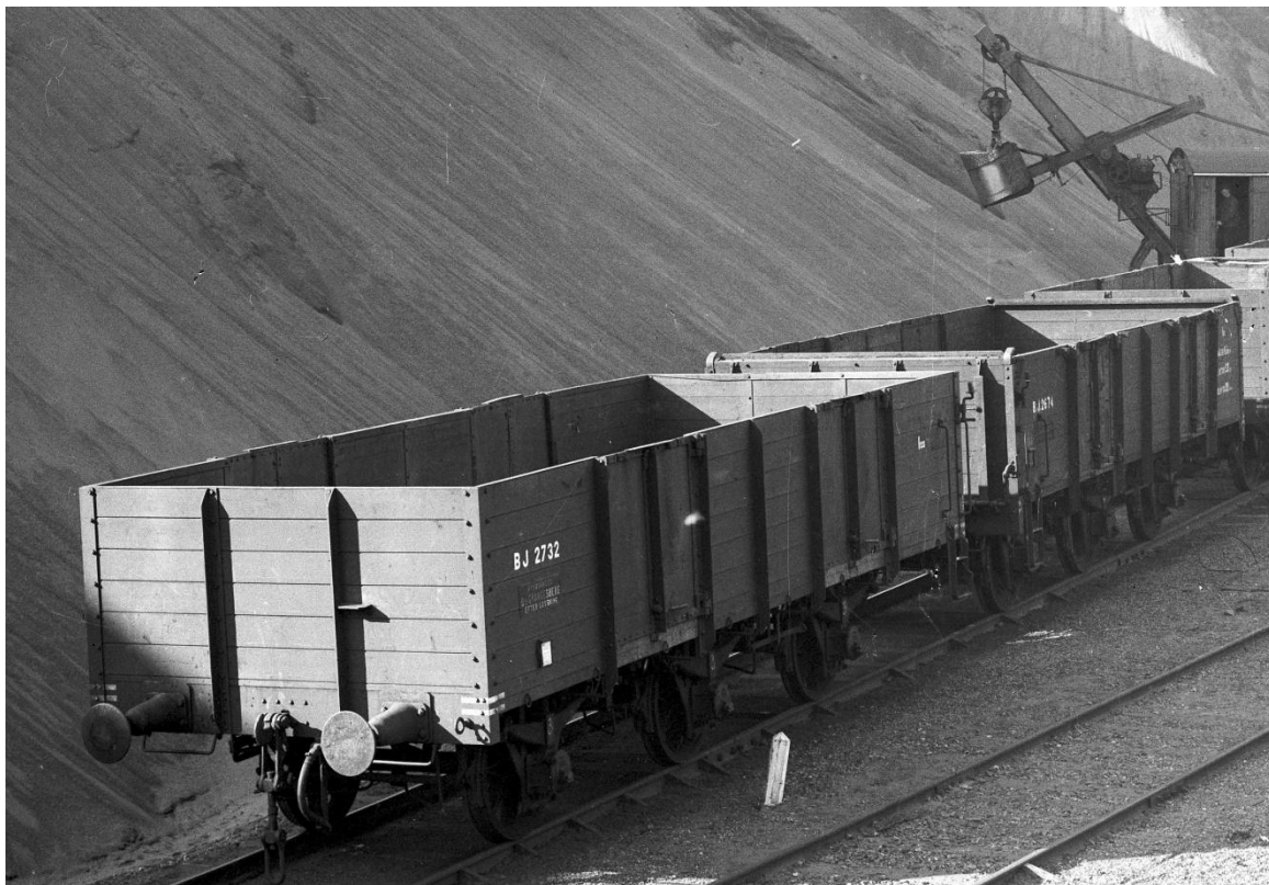
Figur 5. BJ 2732 Iss i Grängesberg, med förenklad målad märkning och med tryckluftsbroms och med skruvbromsutrustningen avlägsnad. Till höger BJ 2674. (F9) beskuren.
